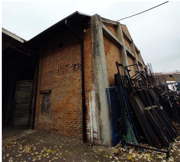
Slika 3.5. Betonski stabilizacijski okvir na južnoj strani zgrade 2
