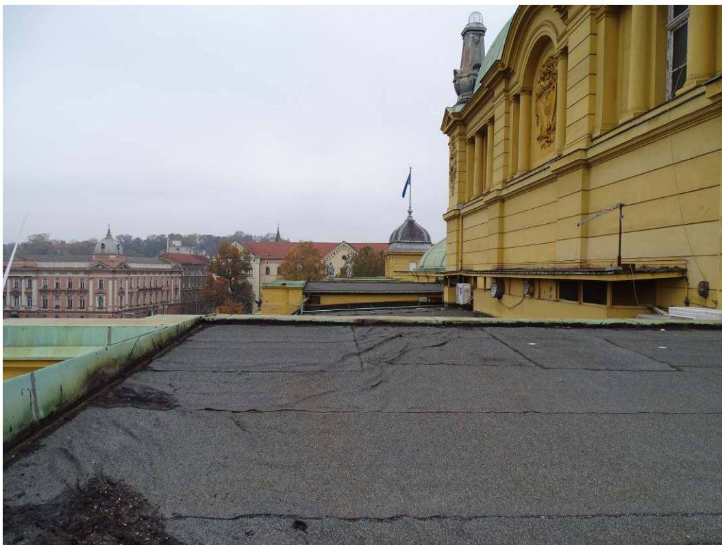
Pogled na jugozapadni dio ravnog krova
