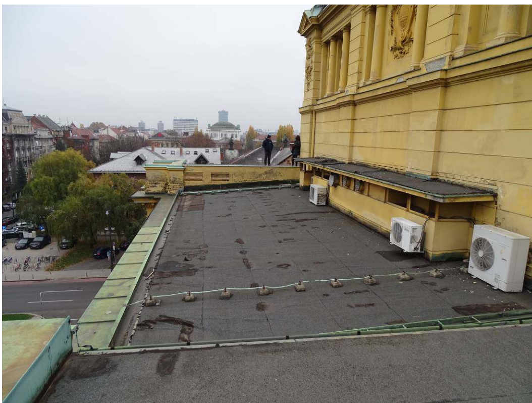
Pogled na jugoistočni dio ravnog krova
