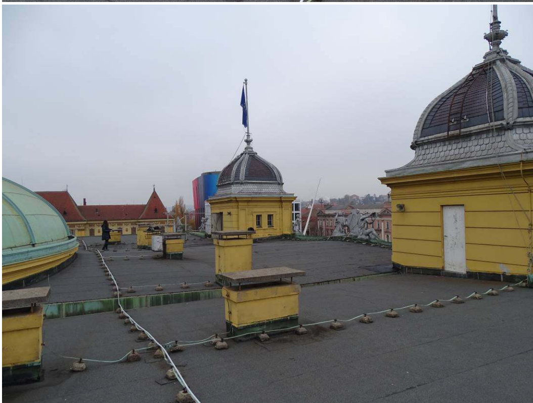
Pogled na sjeverni dio ravnog krova
